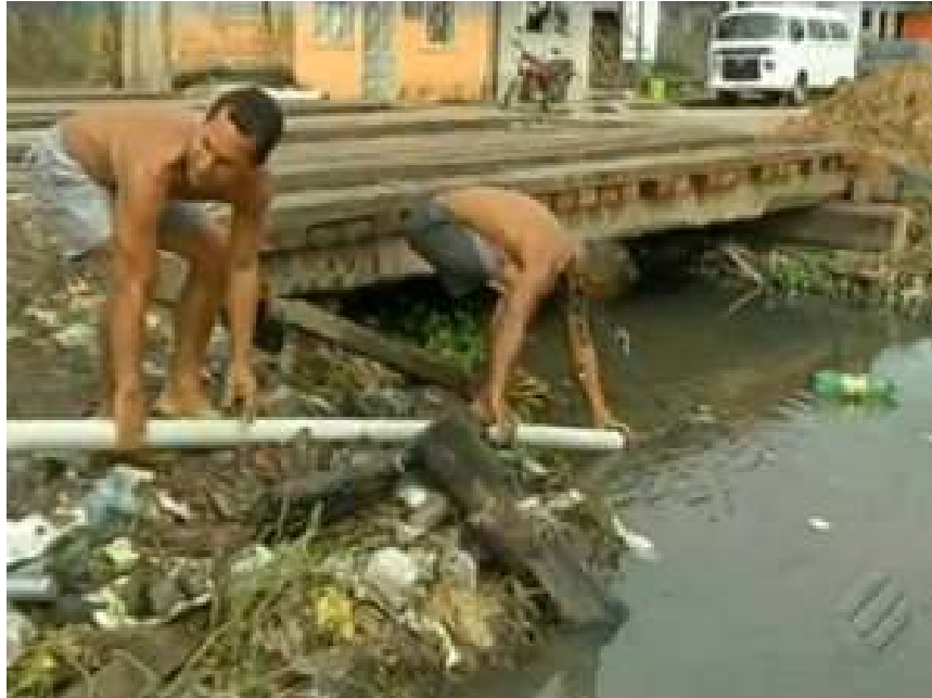
Figura 10: Moradores improvisaram uma ligação na tubulação.
