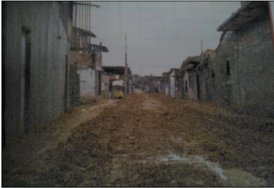
Figura 19: Rua recebendo obra de aterramento.
