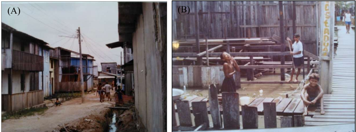
Figura 5: (A) Rua aterrada pelos próprios moradores e a (B) construção de estivas (pontes de madeira).
