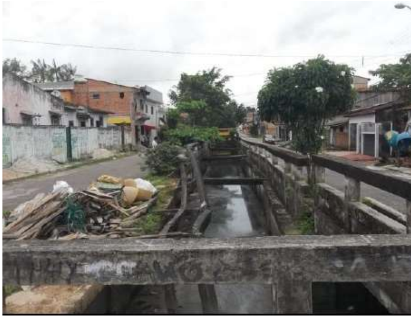
Figura 11: Canal da Angustura: destaque para as condições do canal, ressaltando a falta de manutenção e presença de lixo.
